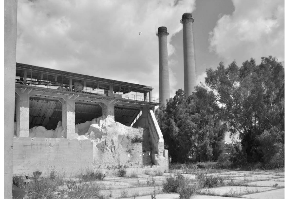
Civitavecchia (Roma). Edificio della macinazione del crudo del ciclo del cemento bianco (foto Riccardo Serangeli, 2014).
