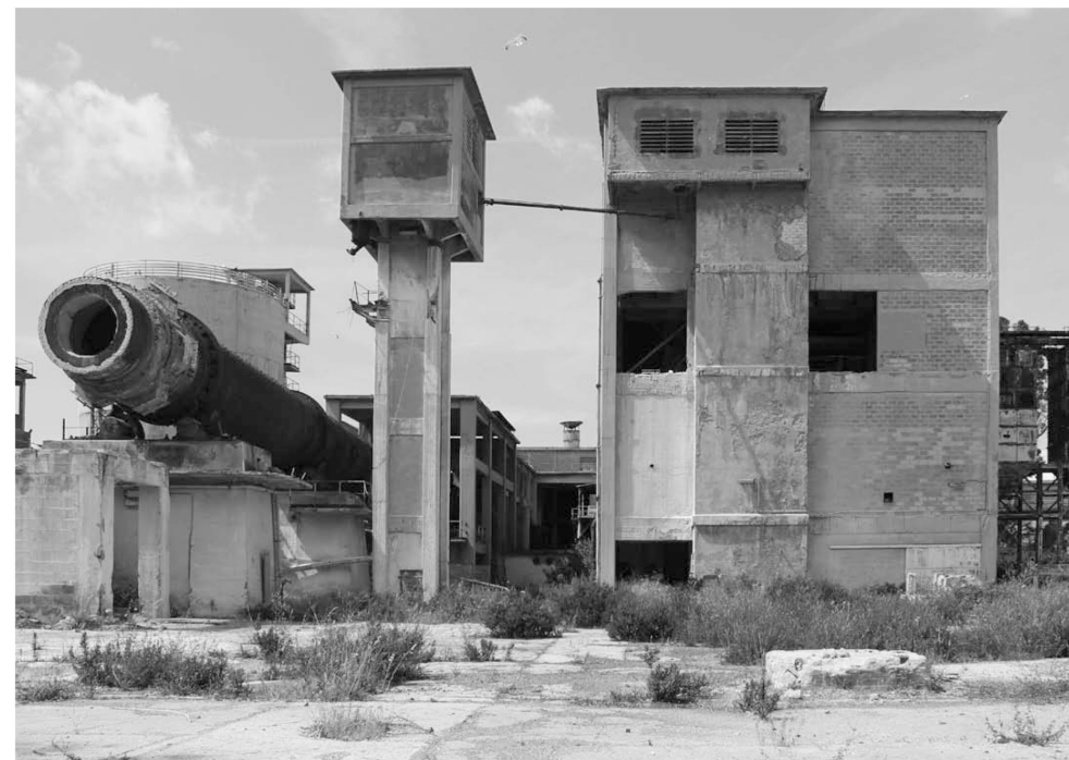
Civitavecchia (Roma). Gli edifici dei forni rotanti (foto Riccardo Serangeli, 2014).
