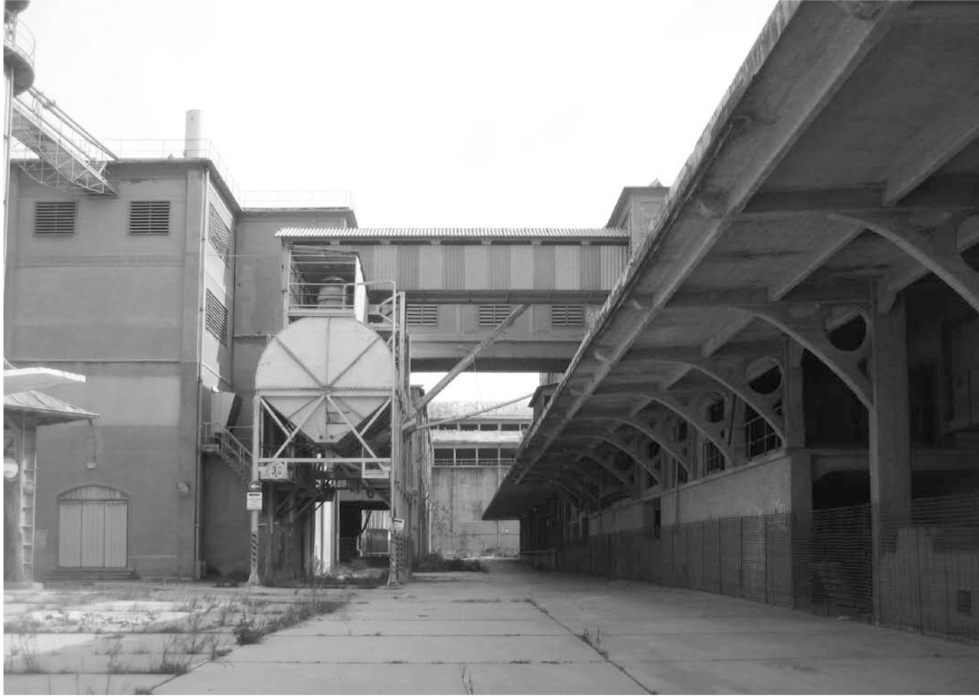
Civitavecchia (Roma). Edifici del ciclo del cemento grigio. A sinistra: la macinazione del crudo. A destra: la macinazione del cotto e la saccheria (foto Riccardo Serangeli, 2014).
